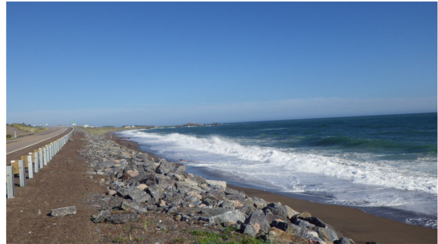
Figure 2-5. État de l'enrochement après les travaux en août 2012 (ch. 0+600 à 0+900)
