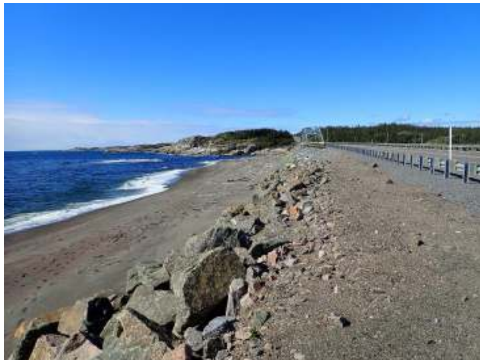
Figure 2-14. Pente de l'enrochement – vue vers l'ouest (ch. 0+400) – septembre 2018
