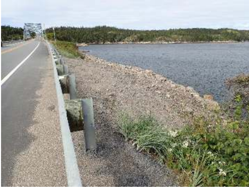
Figure 2-21. Jonction de la rampe en enrochement avec la route 138 – côté nord (ch. 0+180)
