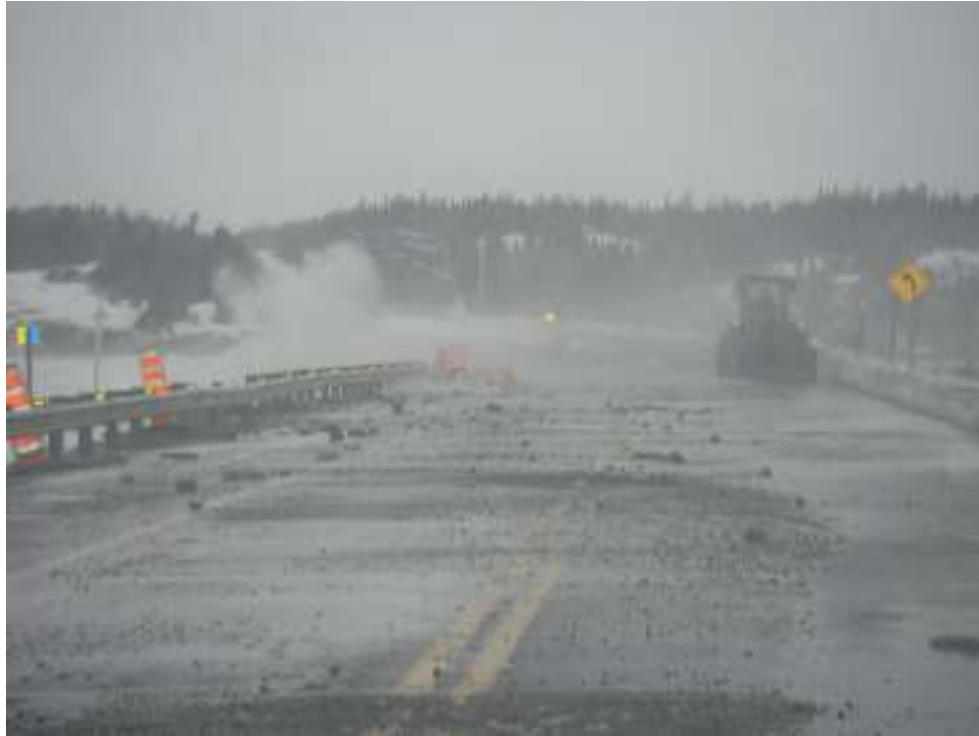
Figure 2-9. Tempête du 11 janvier 2017 – débordement significatif sur la chaussée et au niveau du pont Touzel
