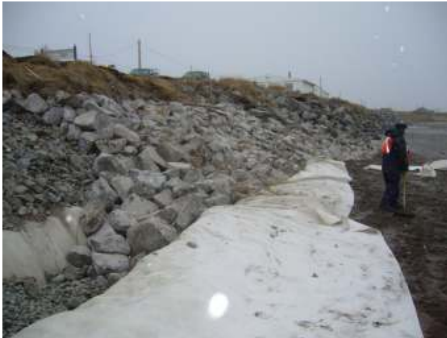
Figure 2-3. Enrochement mis en place devant la poissonnerie en 2006 (ch. 1+998 à 2+090)
