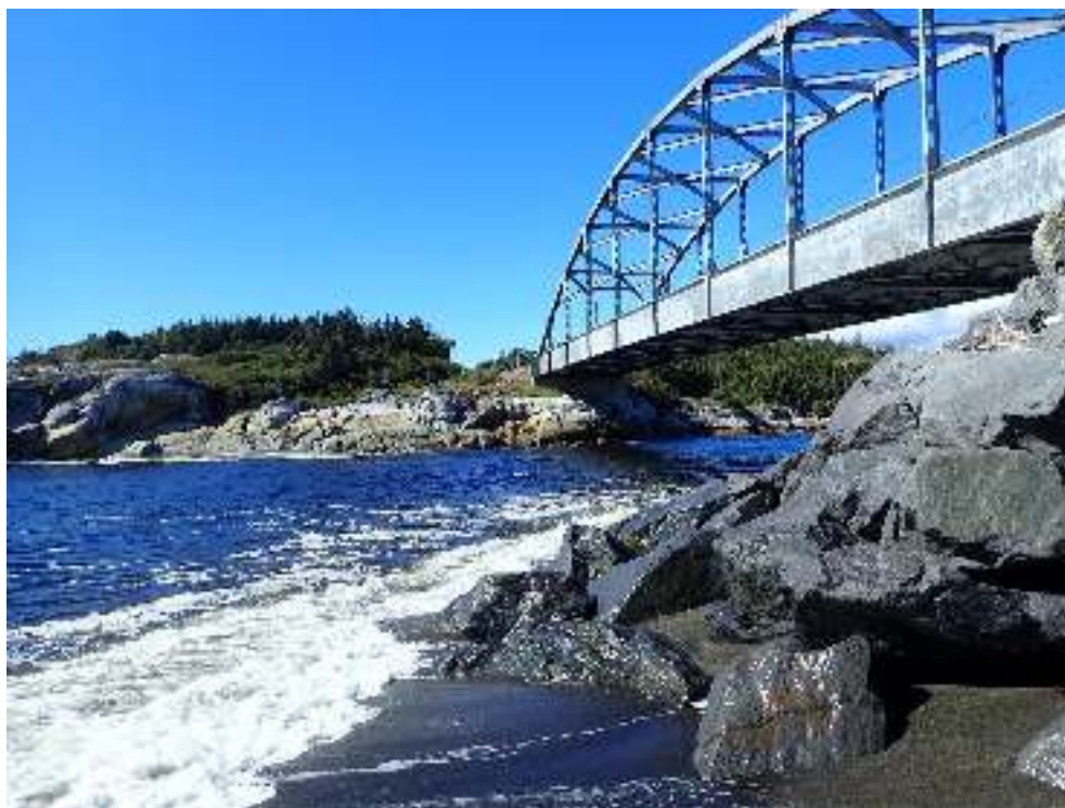
Figure 2-10. Pont Touzel, vue sur la culée ouest reposant sur le roc – (ch. 0+100)
