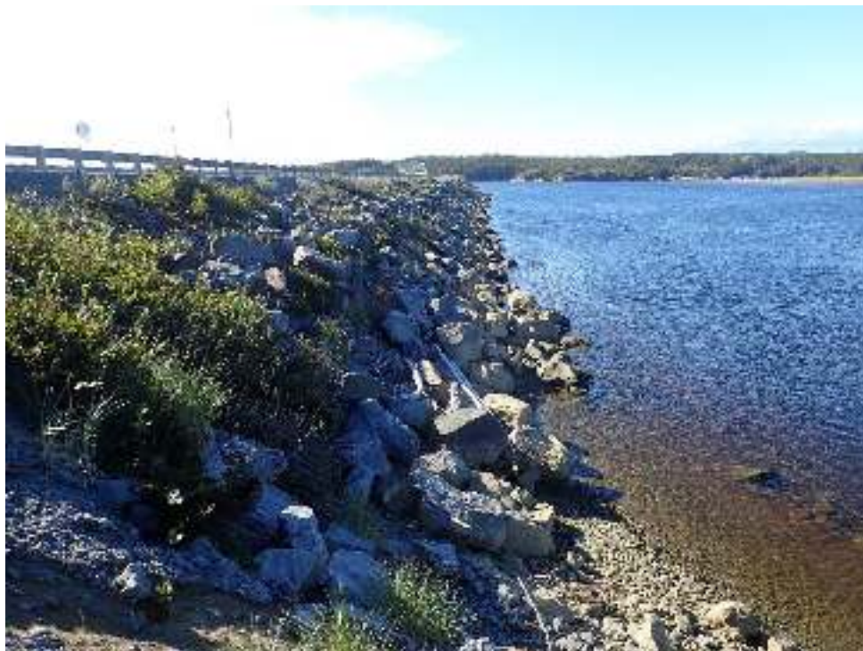
Figure 2-25. Empierrement de protection (ch. 0+540 à 0+700)
