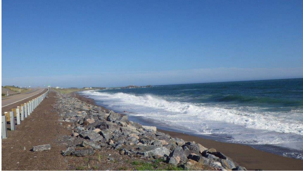
Figure 2-5. État de l'enrochement après les travaux en août 2012 (ch. 0+600 à 0+900)
