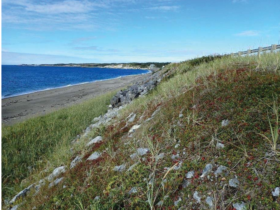
Figure 2-17. Couche de pierres de carapace et présence abondante de végétation (ch. 0+960) – septembre 2018
