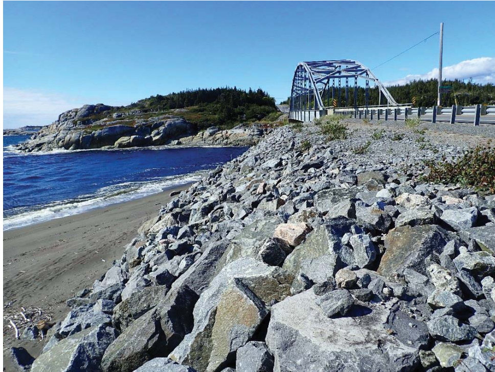
Figure 2-13. Calibres de pierres en place et pente de l'enrochement (ch. 0+150) – septembre 2018
