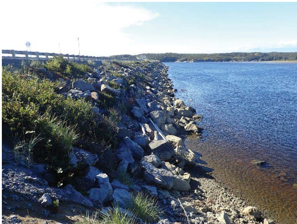
Figure 2-25. Empierrement de protection (ch. 0+540 à 0+700)
