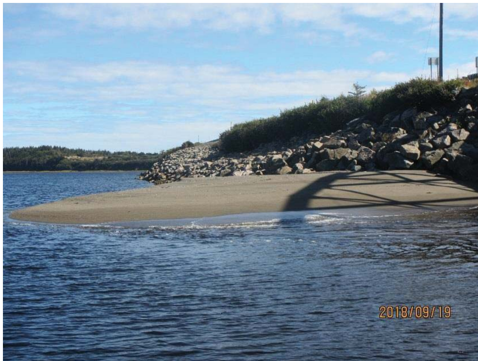
Figure 2-20. Empierrement protégeant le bas de talus et rampe d'accès rejoignant la route 138 (ch. 0+100 à 0+180)
