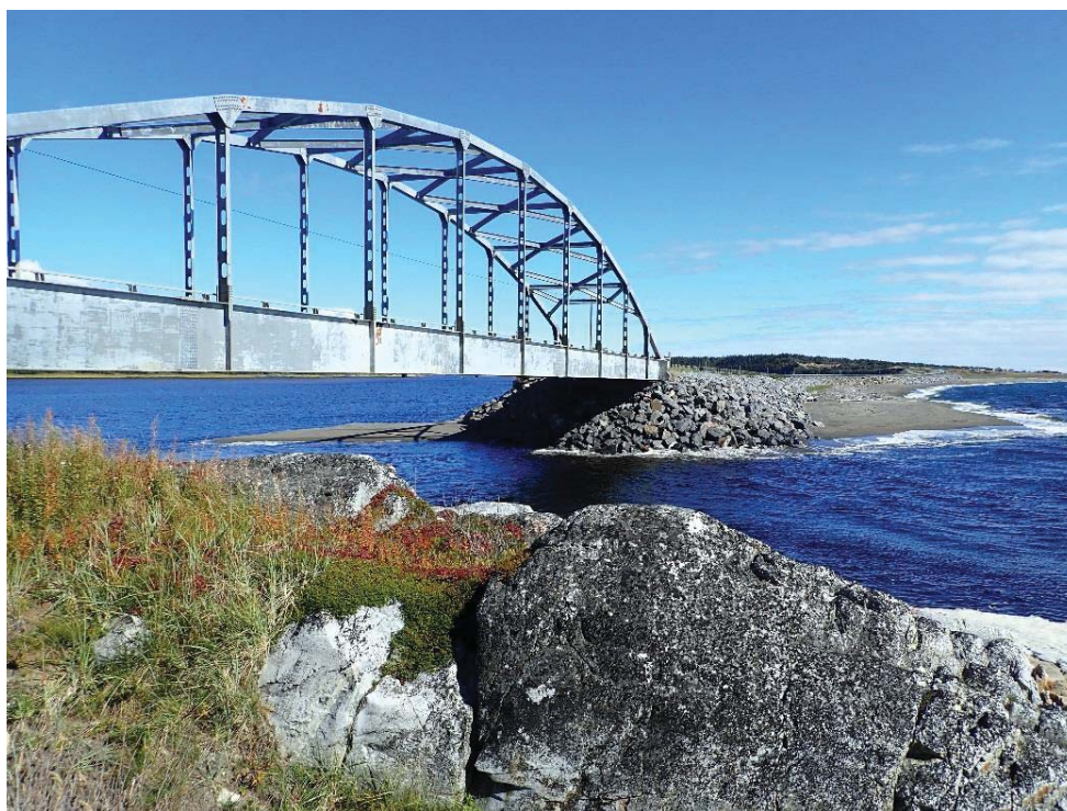
Figure 2-11. Pont Touzel, vue sur la culée est (ch. 0+000) – Septembre 2018
