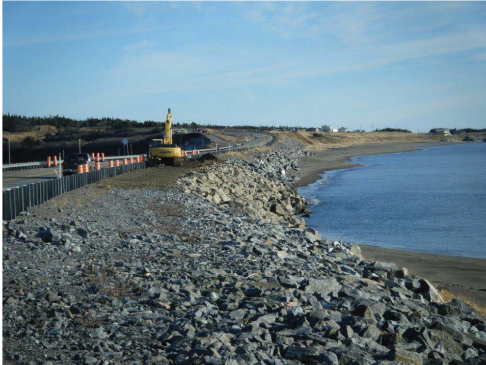
Figure 2-6. État de l'enrochement suite à la fin des travaux vers la fin novembre 2016 (ch. approx. 0+440 à 0+500)
