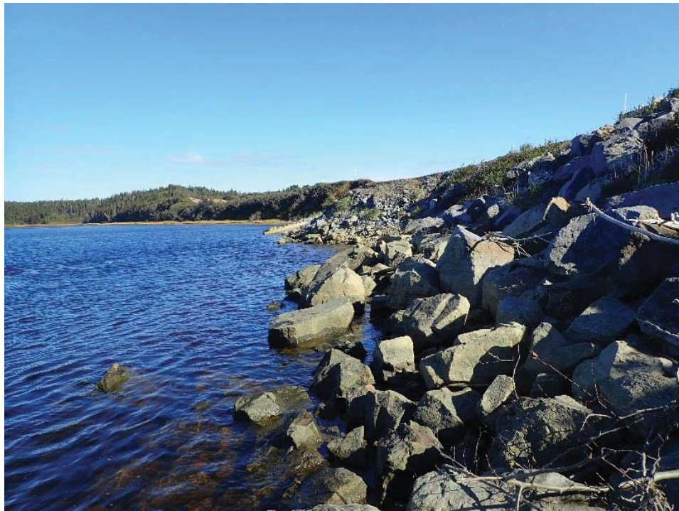
Figure 2-26. Protection en enrochement près de la descente de bateau – ch. 0+700 à 0+800
