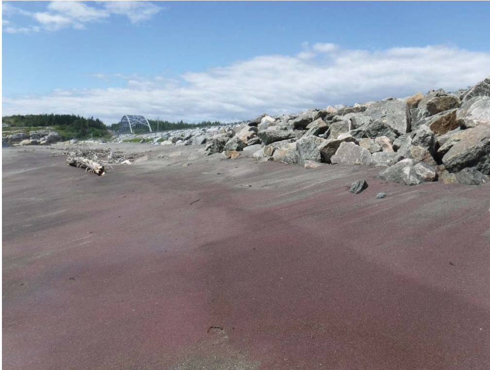
Figure 2-18. Pente de la plage en devant de l'enrochement – présence (ch. 0+150) et absence (ch. 0+300) de berme de plage (plage sèche)
