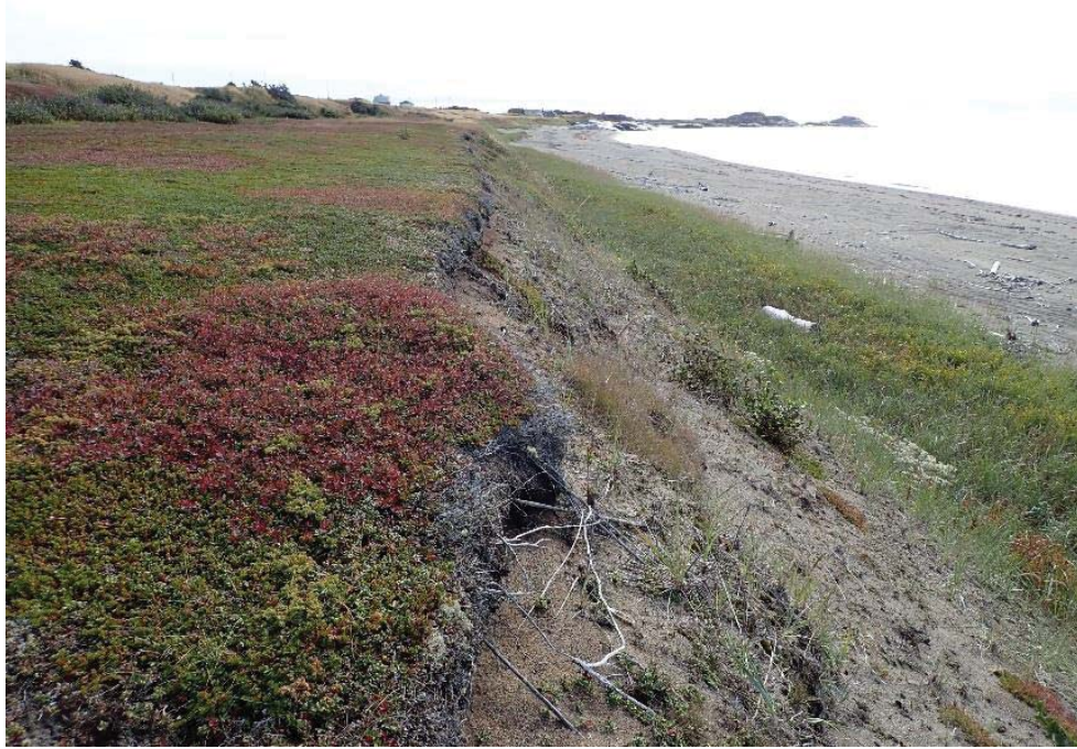
Figure 2-27. Talus de nature sablonneuse avec faible érosion en crête - vue du haut de talus vers le sud-est (ch. 1+100) – septembre 2018
