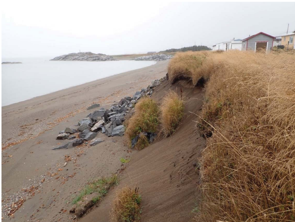
Photo 15 : État actuel de la côte au chaînage 2+300, vue vers l'ouest
