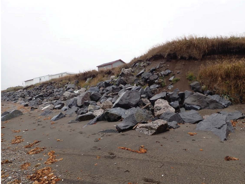
Photo 13 : État de l'enrochement au chaînage 2+250, vue vers l'ouest
