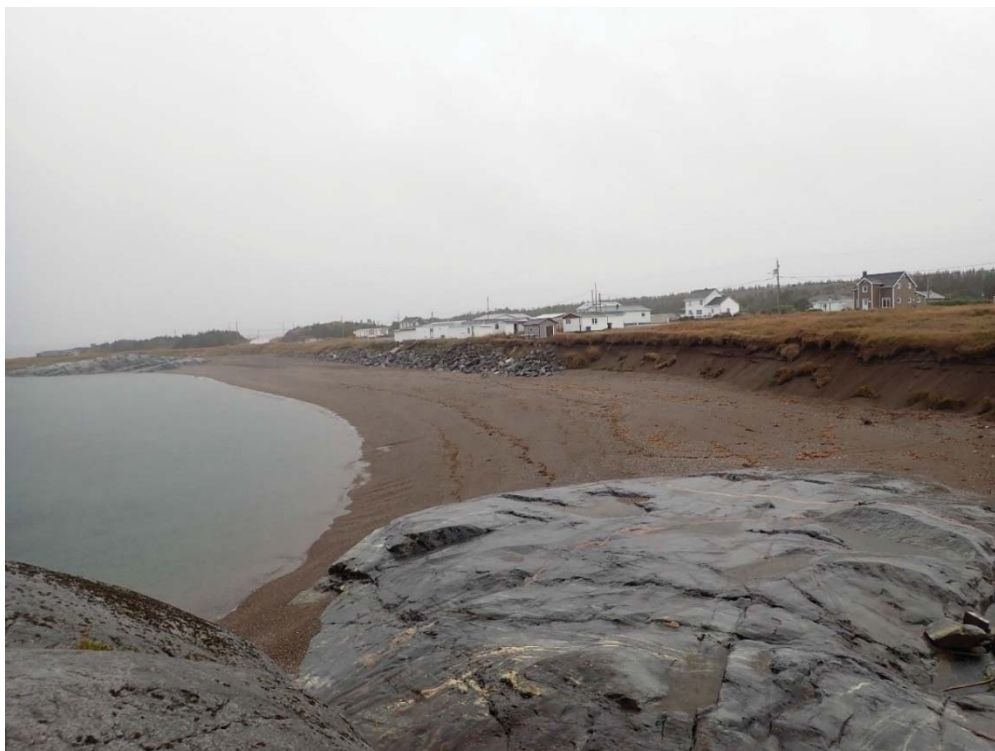
Photo 16 : État actuel de la côte au chaînage 2+500, vue vers l'ouest
