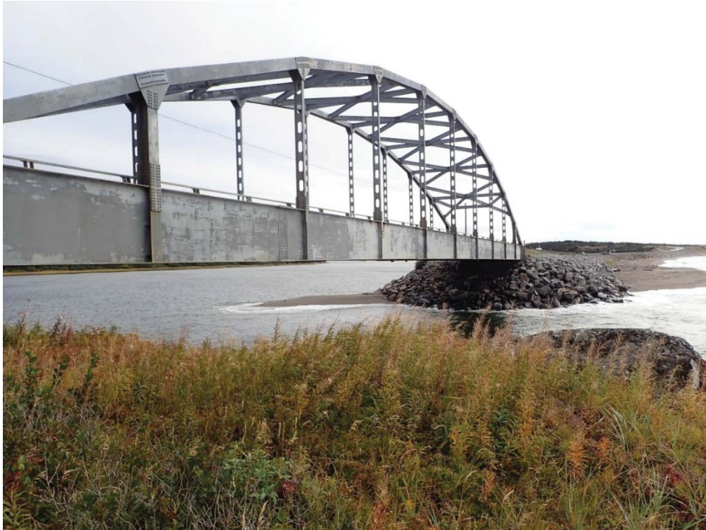
Photo 1: Vue générale du site à l'étude au chaînage 0+000, vue vers l'est
