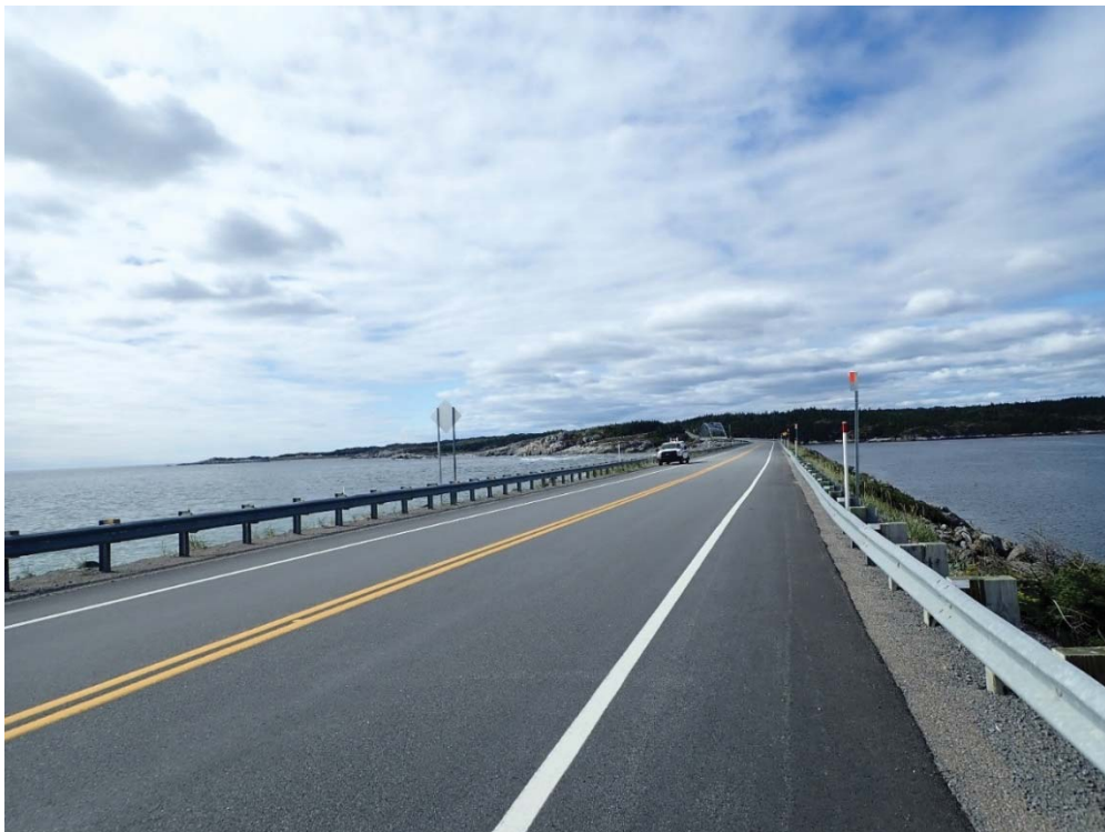
Photo 8 : Vue générale du site à l'étude au chaînage 0+700 vue vers l'ouest
