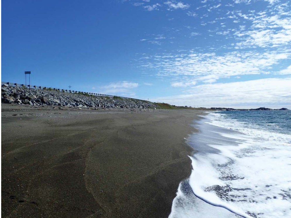
Photo 3 : État de l'enrochement au chaînage 0+300, vue vers l'est
