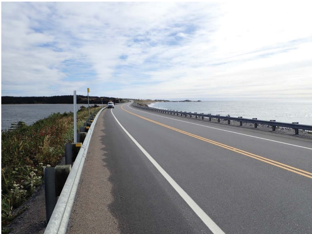
Photo 2 : Vue générale du site à l'étude au chaînage 0+100, vue vers l'est
